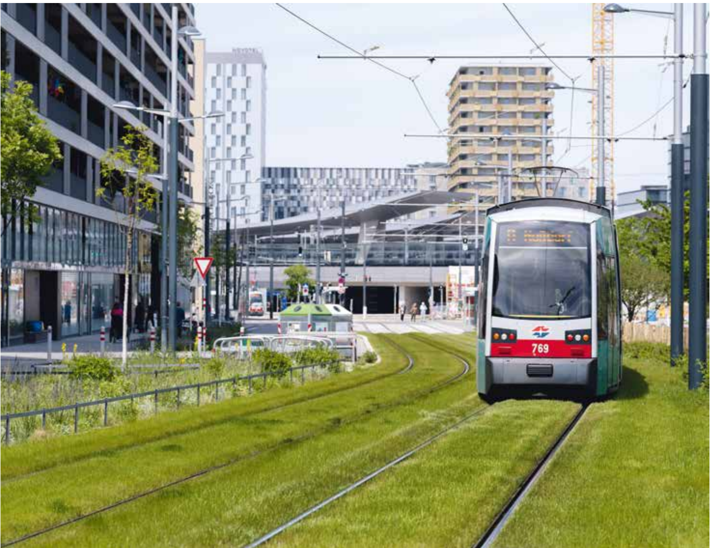
Begrünte Gleise im Sonnwendviertel
